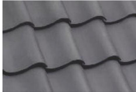
Der gedämpfte Hohlziegel ist die bauzeitlich eingesetzte Dachdeckung (Bsp. Fa. Nelskamp, Hohlziegel gedämpft/144).
