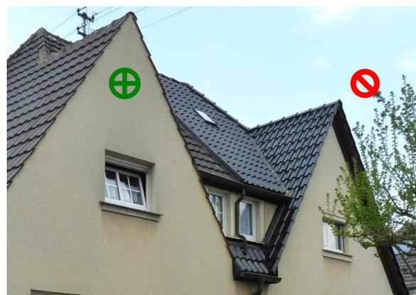
Nicht angepasste Sanierung eines Doppelhausdaches. Die rechte Dachfläche wurde angehoben. Der Dachüberstand ist untypisch. Links das historische Detail.
