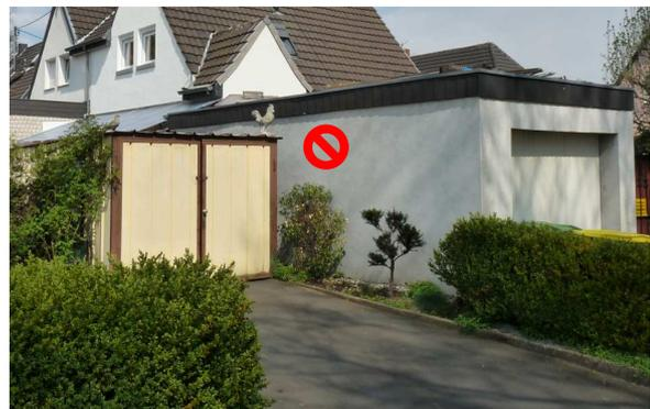
Wichtig ist das von der Straße aus sichtbare Detail der verputzten Front mit dem einzelnen Ziegelabschluss. Als Alternative ist auch ein schlankes und aus Metall gefertigtes Dachrandprofil denkbar. Nicht zulässig ist die Betonung des Dachrandes durch andere Verkleidungsmaterialien.
